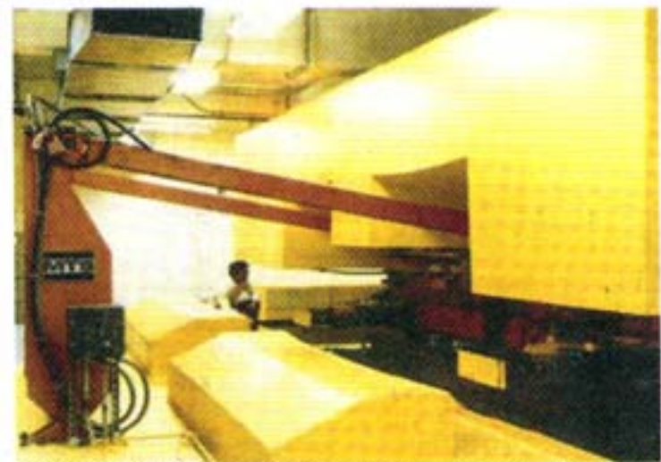
มวลขนาดใหญ่อยู่บนตึกชั้นบน ไว้สำหรับหน่วงการสั่นของตึกสูง
