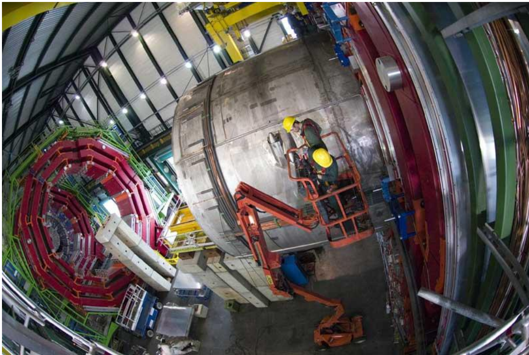
ภาพ ของเจ้าหน้าที่ขณะกำลังติดตั้งเครื่องซีเอ็มเอสซึ่งปัจจุบันติดตั้งเสร็จแล้ว
