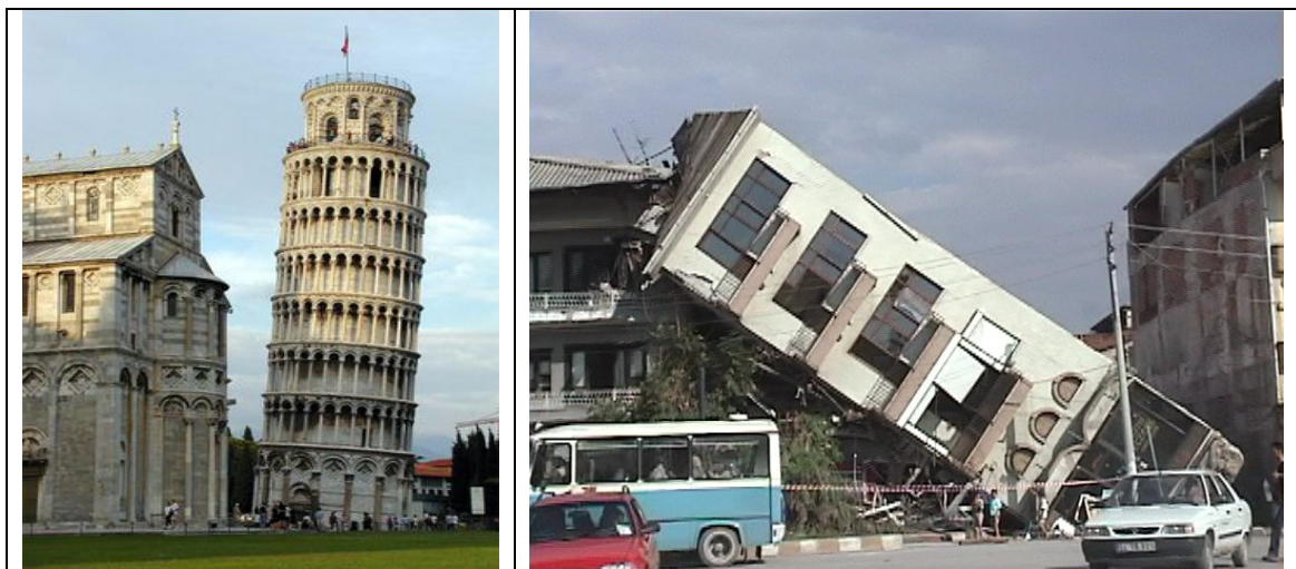
รูป 1.7 อาคารที่มีรากฐานไม่แข็งแรง
